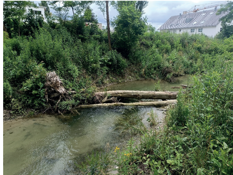
Umgehungsgerinne Schönenwerder Schachen SO ( I = 1.2 - 2.7\text{‰} , Q = 1 \text{ m}^3/\text{s} )
