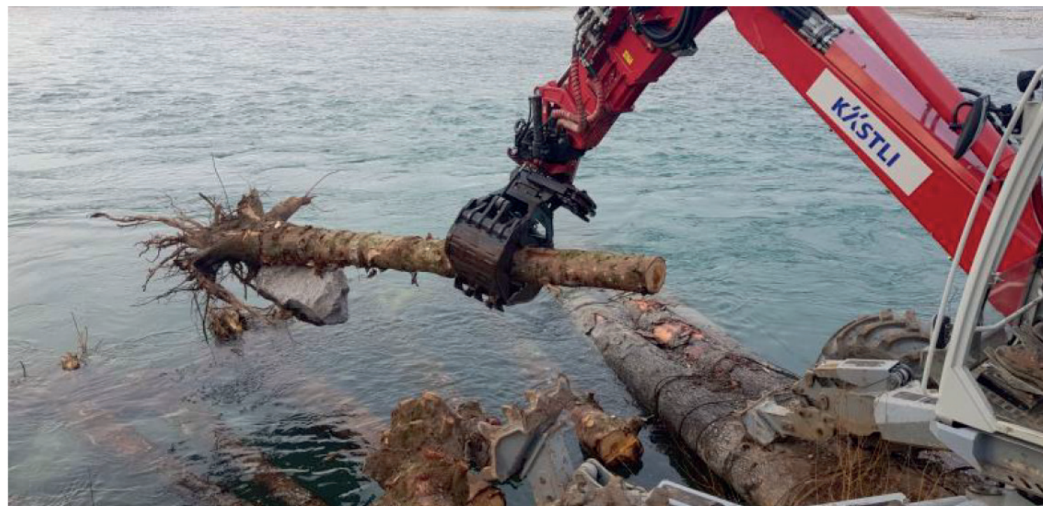
Gruppierte Wurzelstämme an Ankersteinen, Foto: Kästli Bau AG
