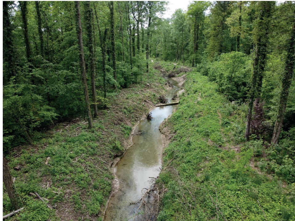
Umgehungsgerinne Schönenwerder Schachen SO ( I = 1.2 - 2.7\text{‰} , Q = 1 \text{ m}^3/\text{s} )
